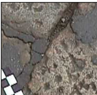
Figura 13: Asportazione di sigillante dai giunti
