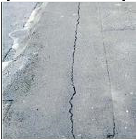
Figura 7: Schema di fessurazione longitudinale
