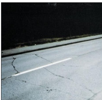
Figura 3: Esempio di fessurazione trasversale
