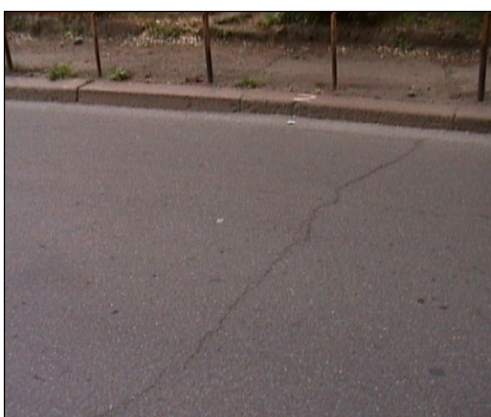
Figura 10: Esempio di fessura trasversale
