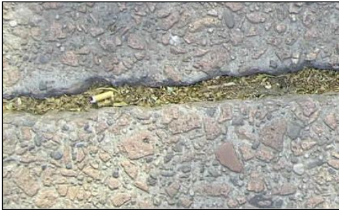
Figura 4: Degrado dei giunti non sigillati
