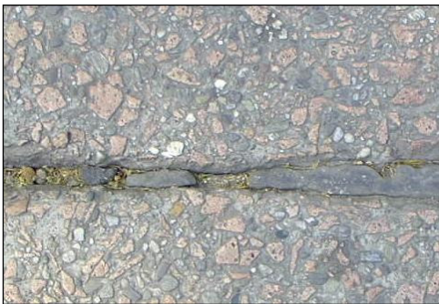
Figura 5: Degrado dei giunti precedentemente sigillati
