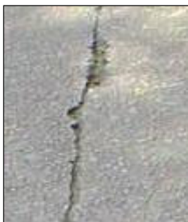
Figura 2: Esempio di fessurazione longitudinale
