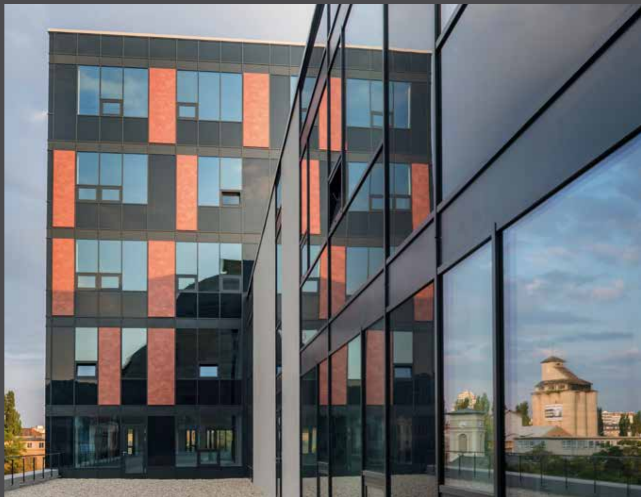
Stein 2 Office Building, Bratislava | Matériau/Materiale: ALUCOBOND® PLUS Coracero B mat | Architecte/Architetto: Ateliér Ivan Kubik Transformateur/Trasformatore: ALUSTEEL | © Martin Viazanko
